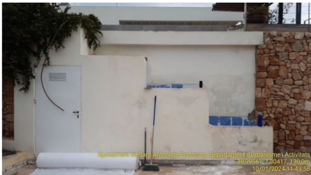
foto 2024: sustitución escalera por rebosadero piscina y zona técnica piscina.
