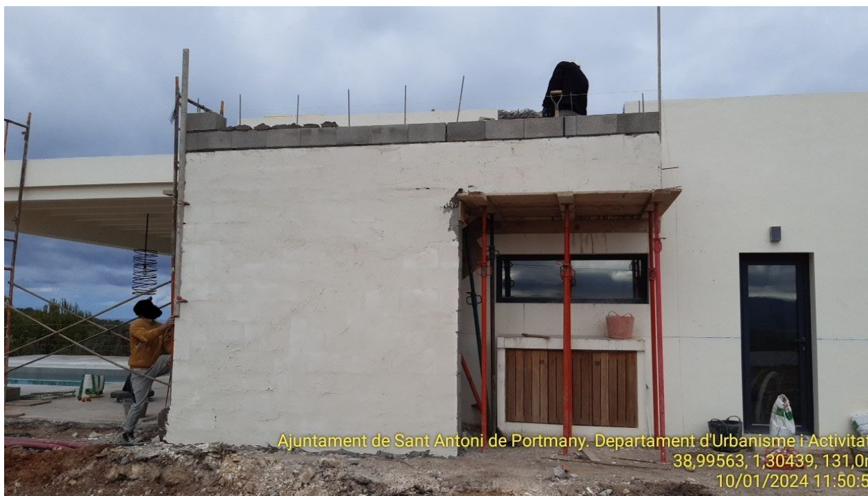
Foto 2024:nueva escalera de acceso a la planta piso en curso de ejecución.
