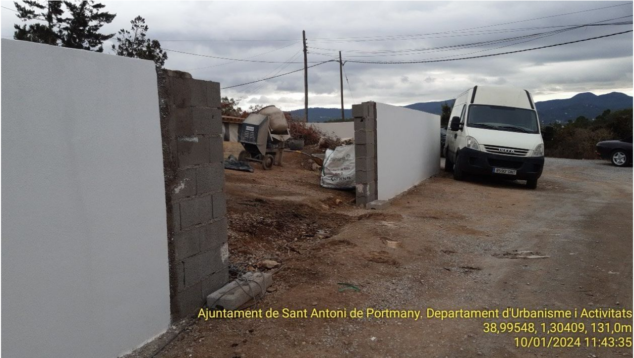
Foto 2024: muro cerramiento en curso de ejecución
