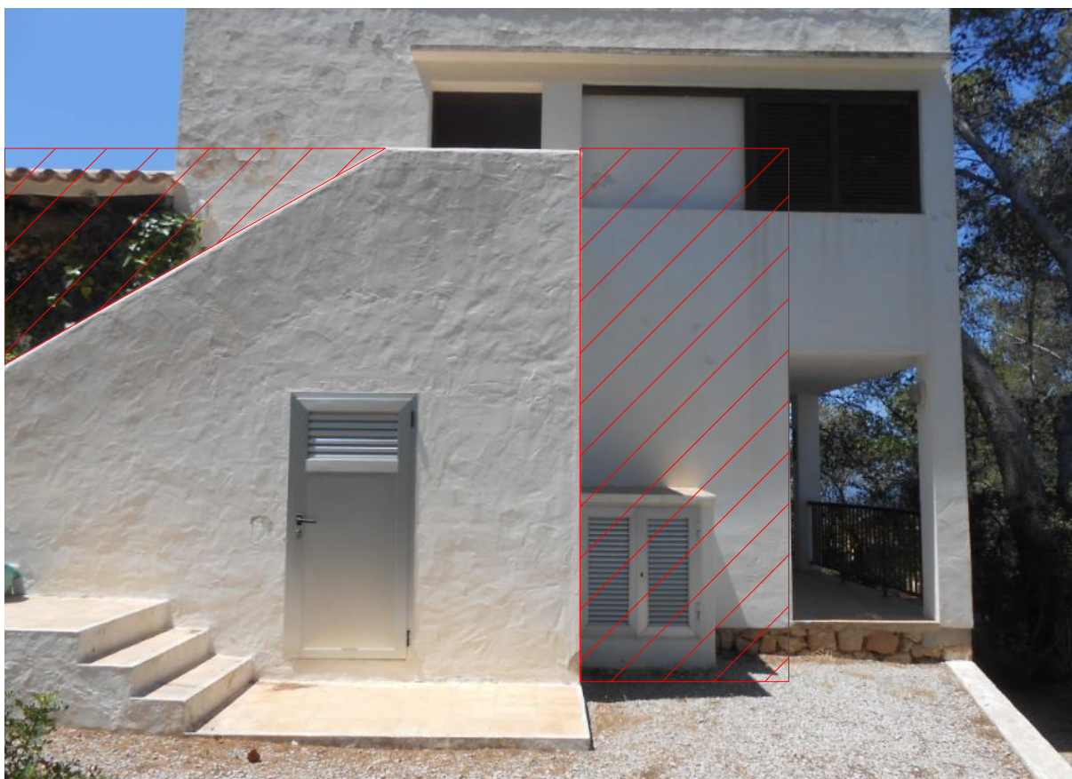
foto 2016: escalera acceso planta piso, puerta tipo almacén
